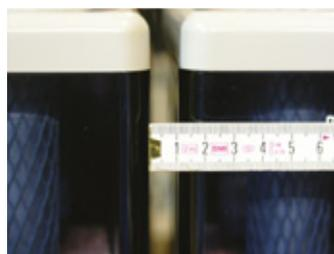
Fig. 5-13 : 10 mm d'écart entre les éléments de batterie
