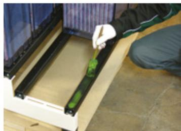
Fig. 5-12 : Traitement des rails d'installation
