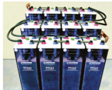
Fig. 5-16 : Utilisation de connecteurs de lignes et de gradins
